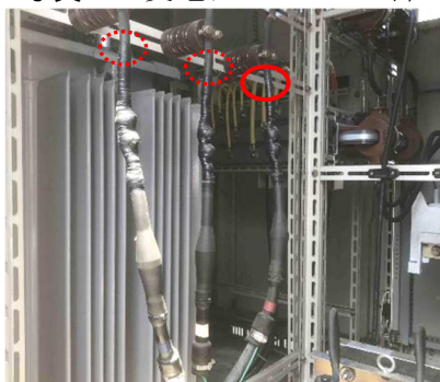
写真 1 受電ケーブル立上部
